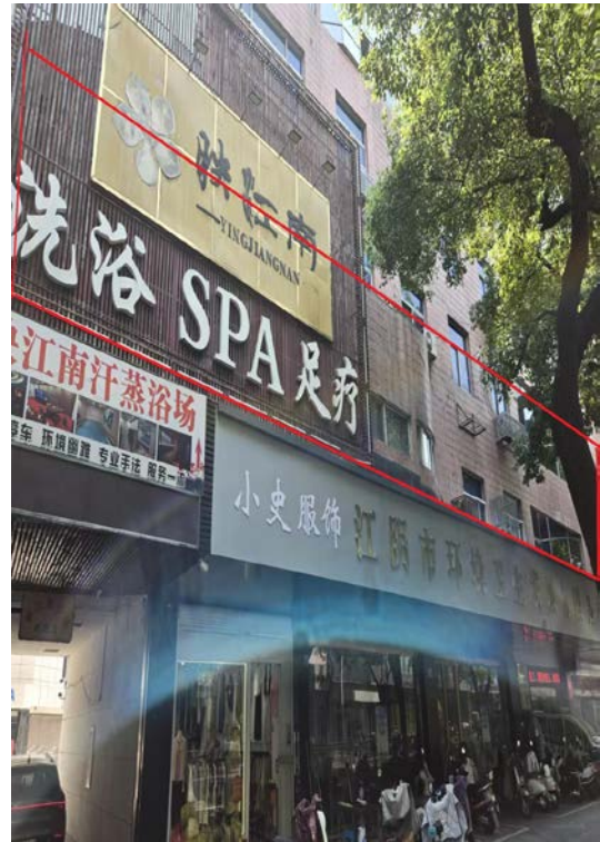
中山北路 56 号综合大楼二楼
