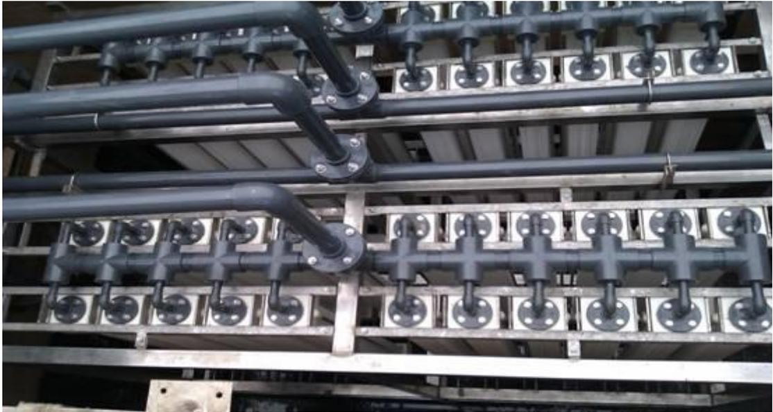
图 6-3 气震膜组件安装于浆池中
