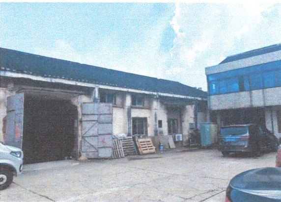
山观粮管所（西街124号）4-5号仓库
