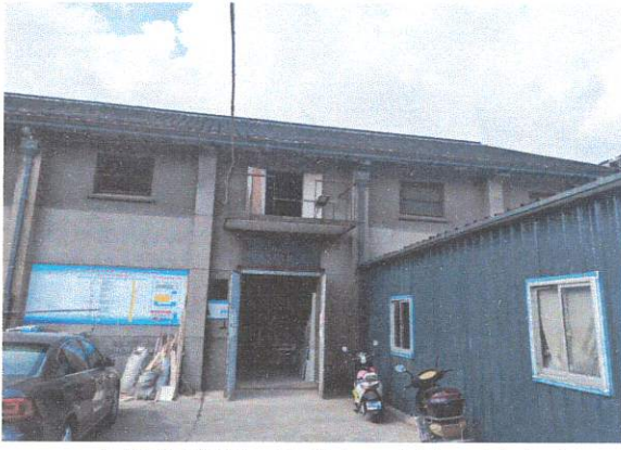
山观粮管所（西街124号）1号仓库
