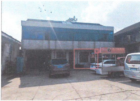
山观粮管所（西街124号）办公楼底北
