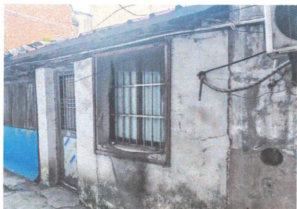
陆桥粮管所河西库辅房(义庄路14号)
