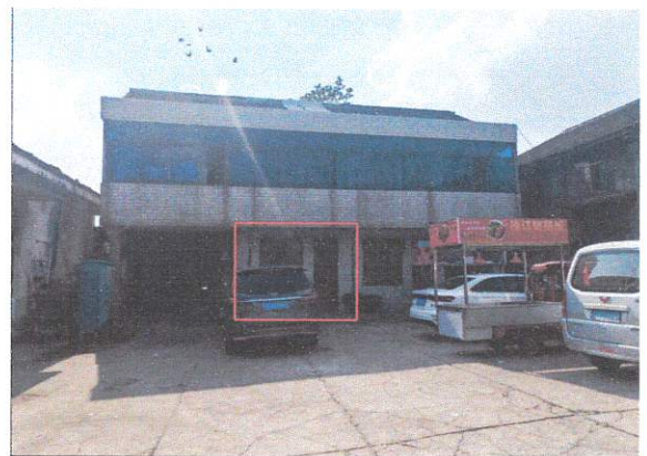
山观粮管所（西街124号）办公楼底南
