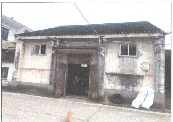
山观粮管所（西街124号）6号仓库
