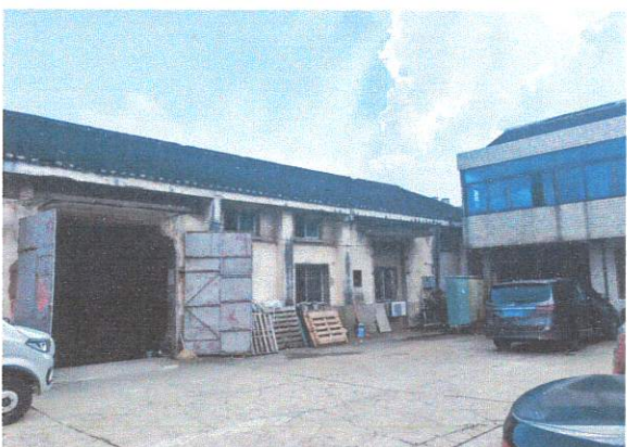
山观粮管所（西街124号）4-5号仓库
