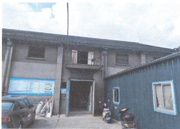
山观粮管所（西街124号）1号仓库
