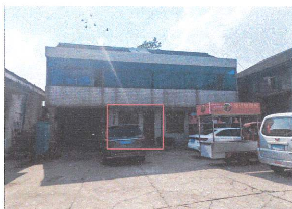
山观粮管所（西街124号）办公楼底南
