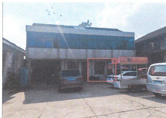
山观粮管所（西街124号）办公楼底北
