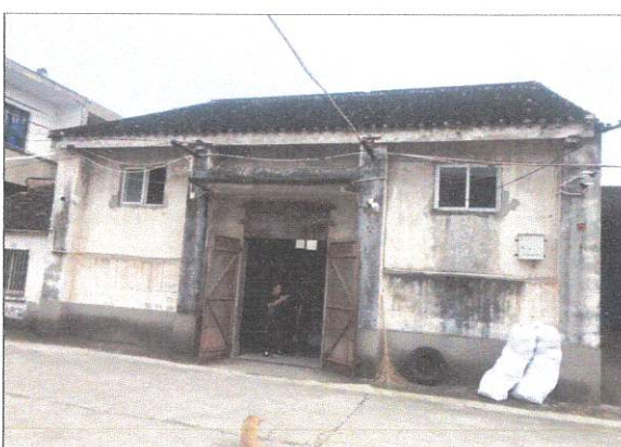
山观粮管所（西街124号）6号仓库
