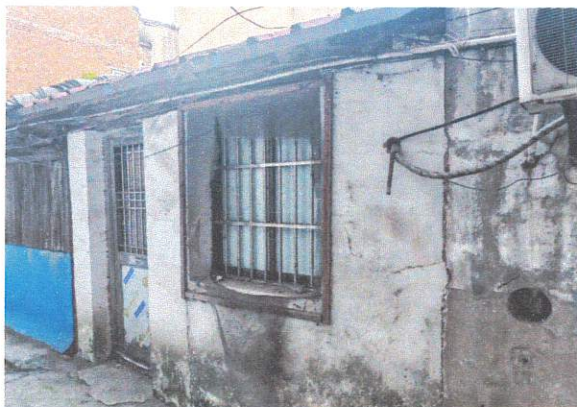
陆桥粮管所河西库辅房(义庄路14号)
