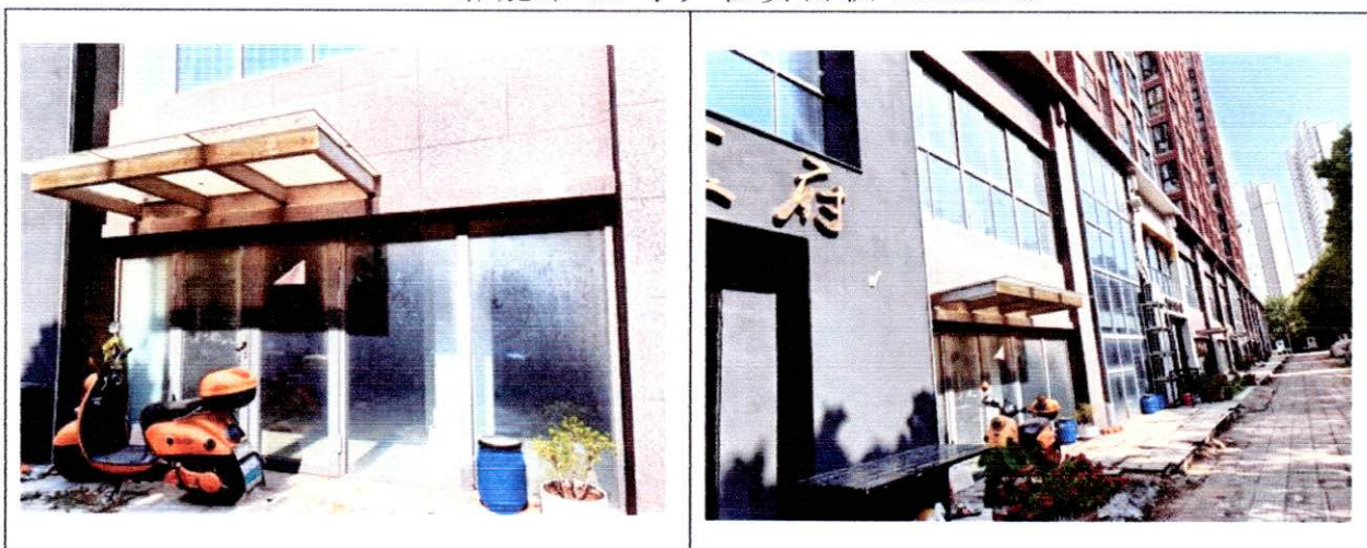
春麓路 2 号，位于黄山小区二期，春麓路与滨江路交叉口东北侧，1
